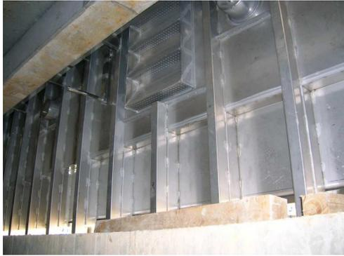
Des profils de raidissage des parois en inox permettent une grande planimétrie (visite néanmoins nécessaire)
