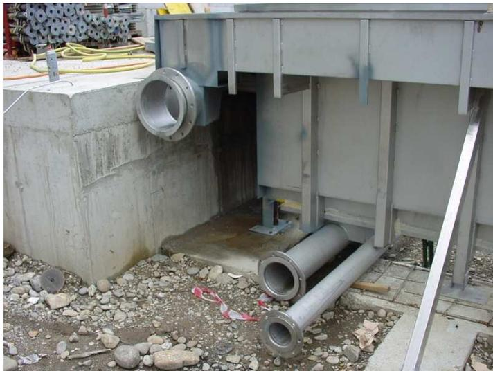
L'arrivée d'eau se fait dans le fond du bassin sous formes de plusieurs lignes de caniveaux avec répartiteur à l'intérieur.
