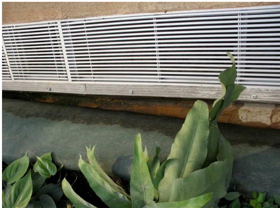
La diffusion d'air sera en général réalisée devant les parois froides, au moyen de diffuseurs à fentes ou de banquettes de soufflage situés sur les plages.
