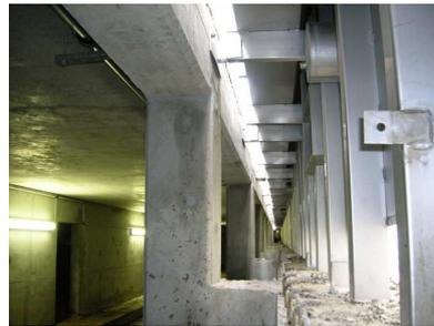
Des supports seront soudés au dos des tôles de paroi polies, côté eau, sur lesquels seront positionnées les consoles servant au montage des goulottes de débordement.
