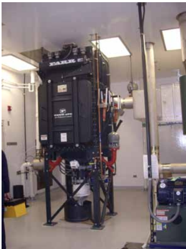
Collecteur de poussières de confinement complet Camfil Farr APC avec système antidéflagrant
