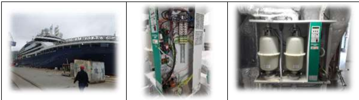
Installation de l'ELMC sur le navire
