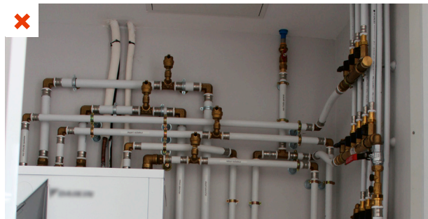
Les indications des éléments de l'installation ont bien été posées, mais le calorifugeage n'ayant pas encore été réalisé, l'ensemble des informations risquent de disparaître sous l'isolant. ©AQC
