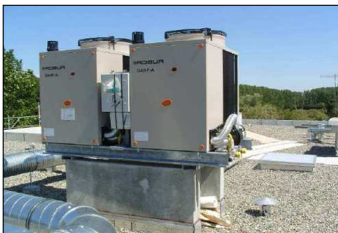
Figure 1 : Les deux PAC installées en toiture terrasse
