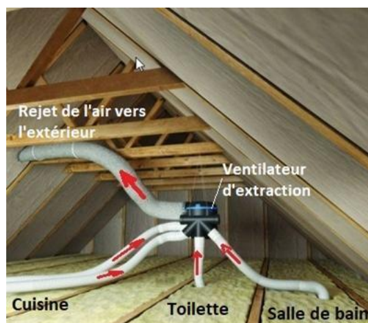
VMC (ventilation mécanique contrôlée simple flux)
