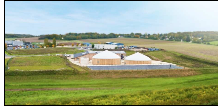
Chantier Gâtinais Biogaz (45)
