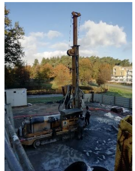
Forage pour sonde verticale
