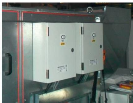
**Le Kit CTA 0-10 volts de TOSHIBA se destine aux bâtiments neufs ou réhabilités sur le marché du grand tertiaire. Il est pré-câblé, ce qui facilite son installation et compatible avec 100 % de l'offre CTA double-flux existante sur le marché.**
