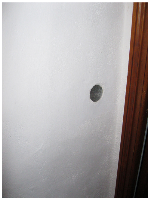
▲ Figure 15 : Orifice de soufflage situé à 1,10 mètre du sol et sans grille de soufflage sur la bouche – Site n°4
