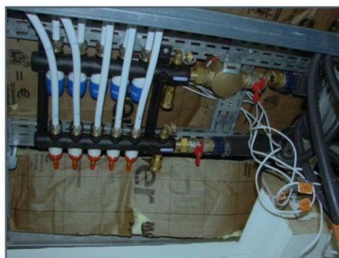
**Figure 7 – Raccordement au collecteur**
