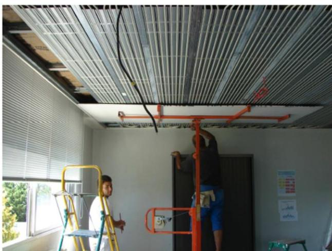
**Figure 8 – Pose du parement**
