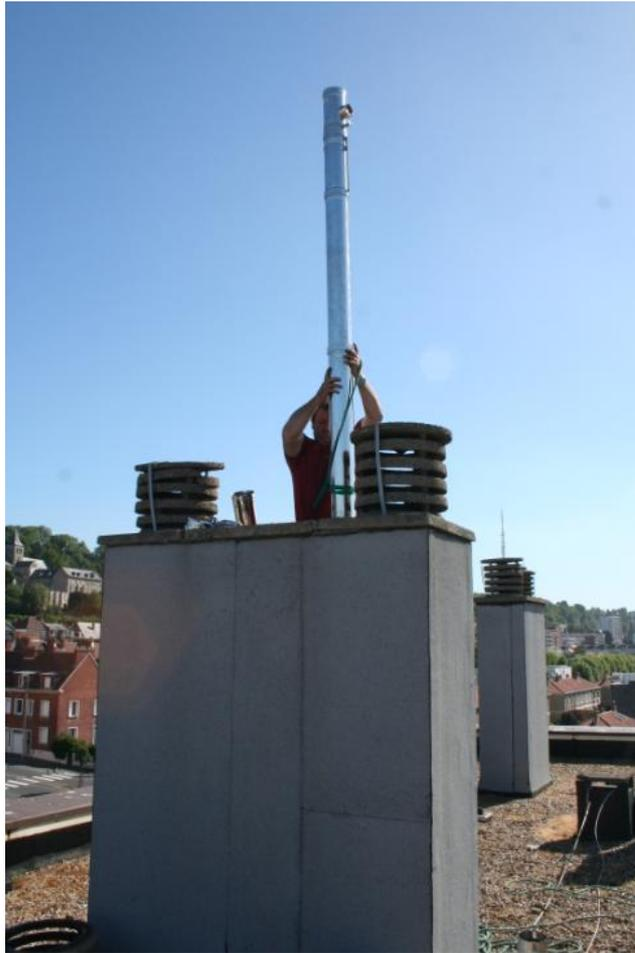
➤ Le tubage est descendu par tronçon de 2,50 mètres jusqu'aux 17 mètres de la hauteur totale du tubage
