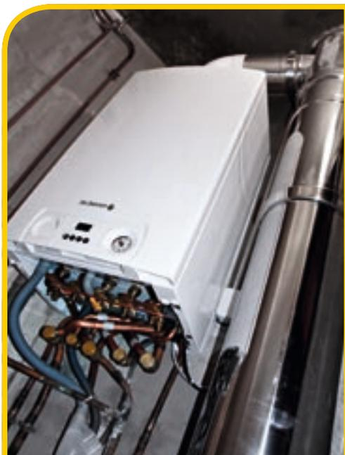
Chaudière à condensation gaz naturel raccordée à un conduit collectif 3CEp installée en alvéole technique
