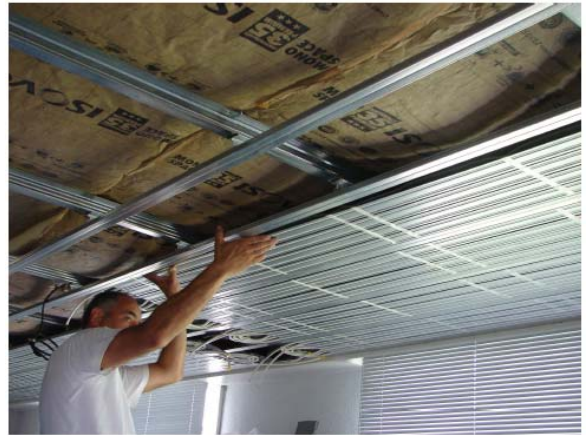
Figure 4 – Mise en œuvre des fourrures et des modules
