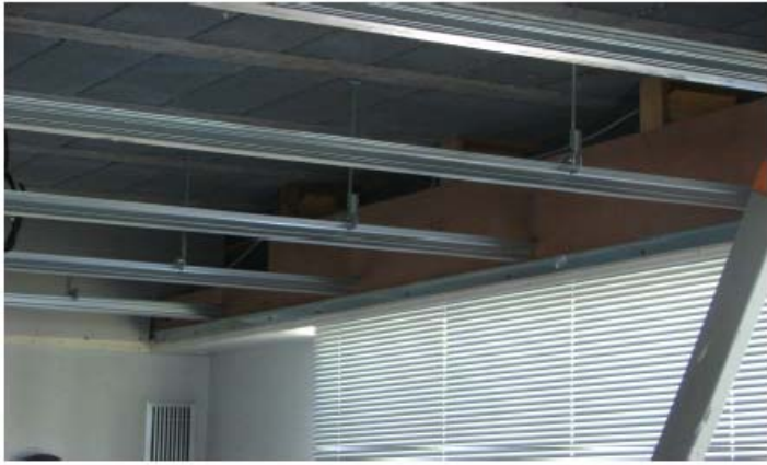
Figure 3 – Mise en œuvre de l'ossature primaire
