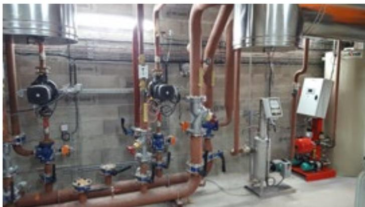
**Intérêt :** Le Groupe de Maintien de Pression - GMP - compense ces variations volumiques et de fait garantit l'intégrité des équipements dans le temps et la distribution homogène d'énergie dans les récepteurs.
