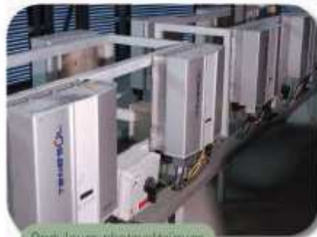
Onduleurs photovoltaïques
