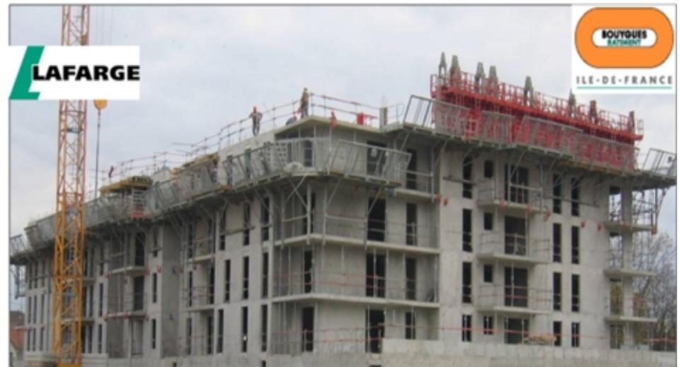
Chantier 3F/ Archi G De CUSSAC
