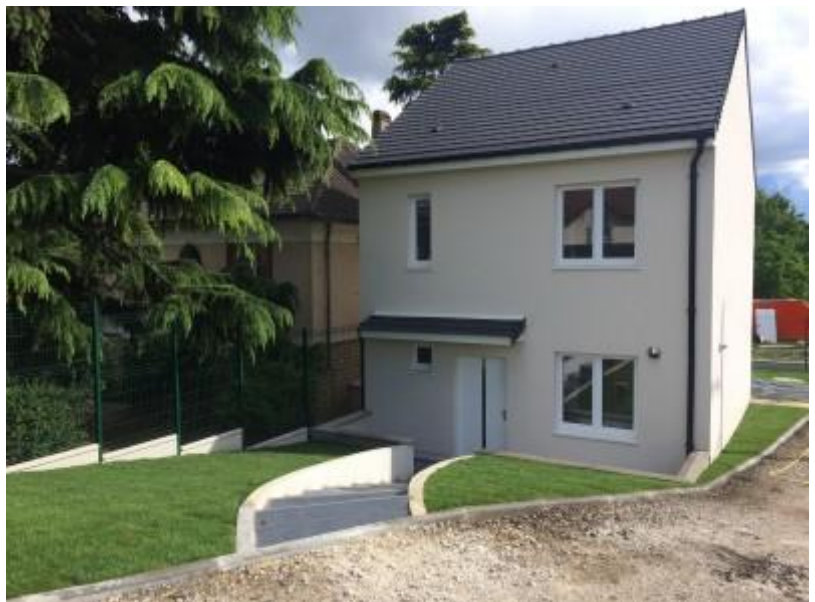
Maison Ecolocost – Ermont – Architecte : Agence Jérôme BRULLE
