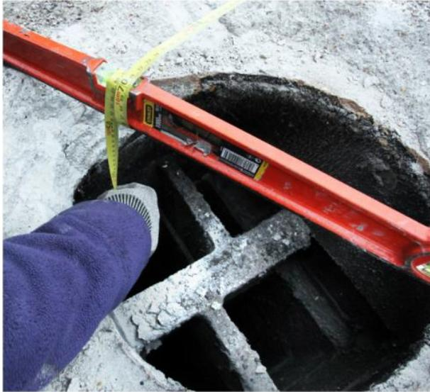
Le relevé de cotes des hauteurs d'étage sera réalisé avec le décamètre plombé par un poids et coincé en tête du conduit maçonné
