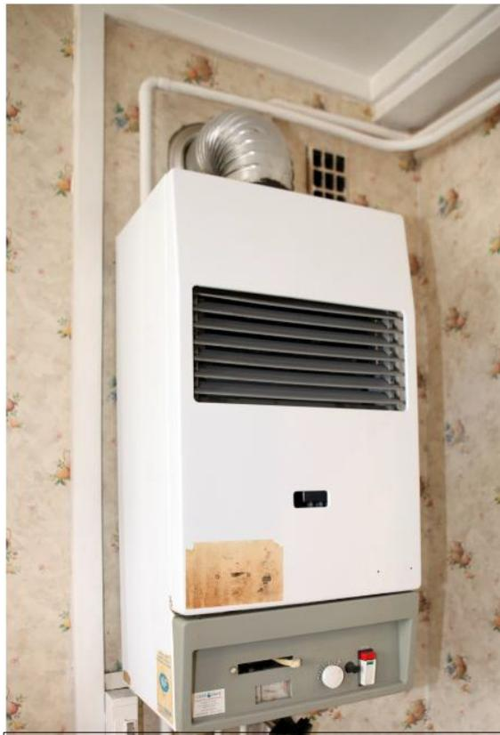
Remarque : le conduit de fumée sur lequel sont raccordées les chaudières est bien un Shunt dédié EVAPDC puisqu'un autre conduit Shunt sert à la ventilation des cuisines.
