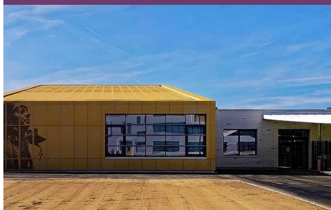
Restauration - Collège St Exupéry - Observatoire BBC
