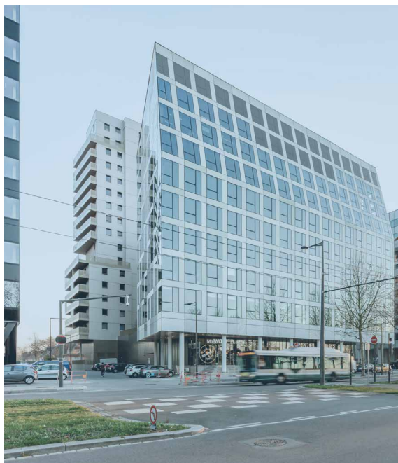
Vision | Strasbourg | Effinergie+ | Architecte : Hubert Godet Architecte | MO : SCI Strasbourg Bd de Dresde
