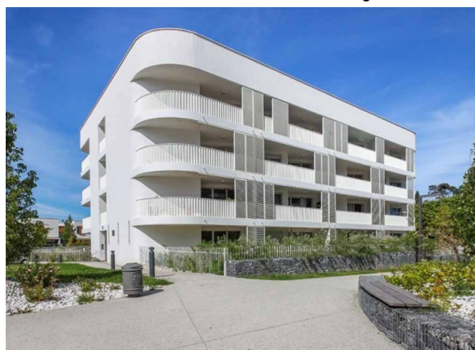
Figure 18 : Résidence Le Carriz - Effinergie+ - MO : Erilia– Architecte : Agence d'architecture Brochet Lajus Pueyo– Biarritz (64)
