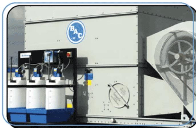
Photo 3. Poste de traitement d'eau typique BAC - Balticare
