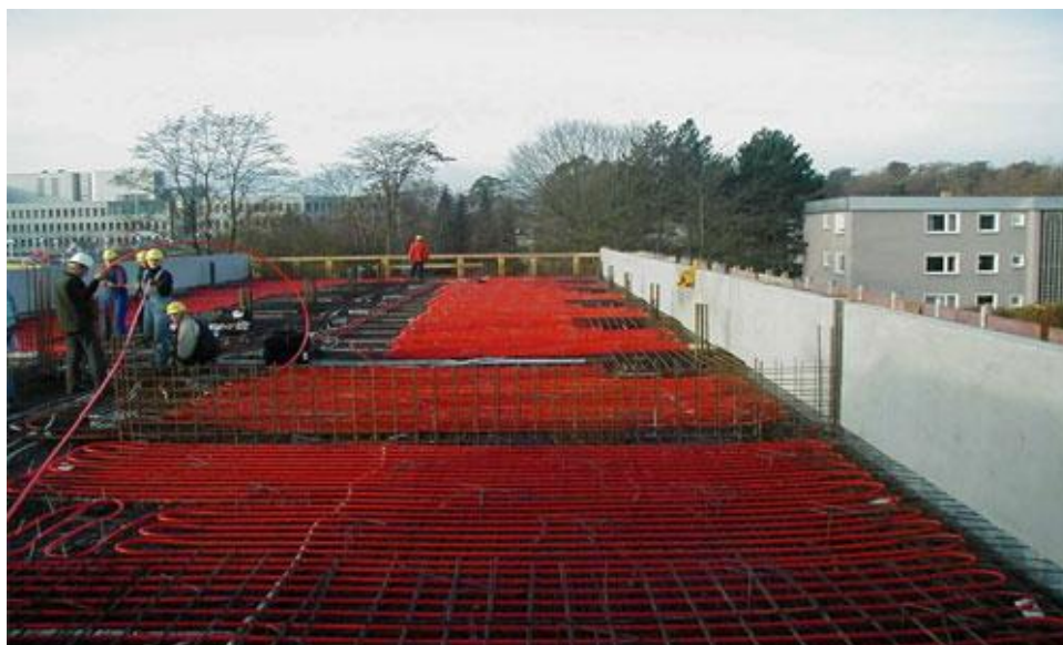
Pose des modules
