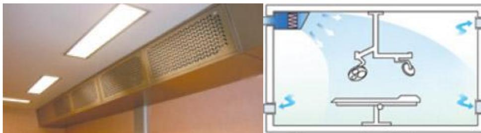
**Le WHINDOP®** est un caisson porte-filtre tout inox à flux dirigé. Tel un bandeau soufflant, l'air balaie latéralement la salle afin d'évacuer la contamination émise autour de la table d'opération.
