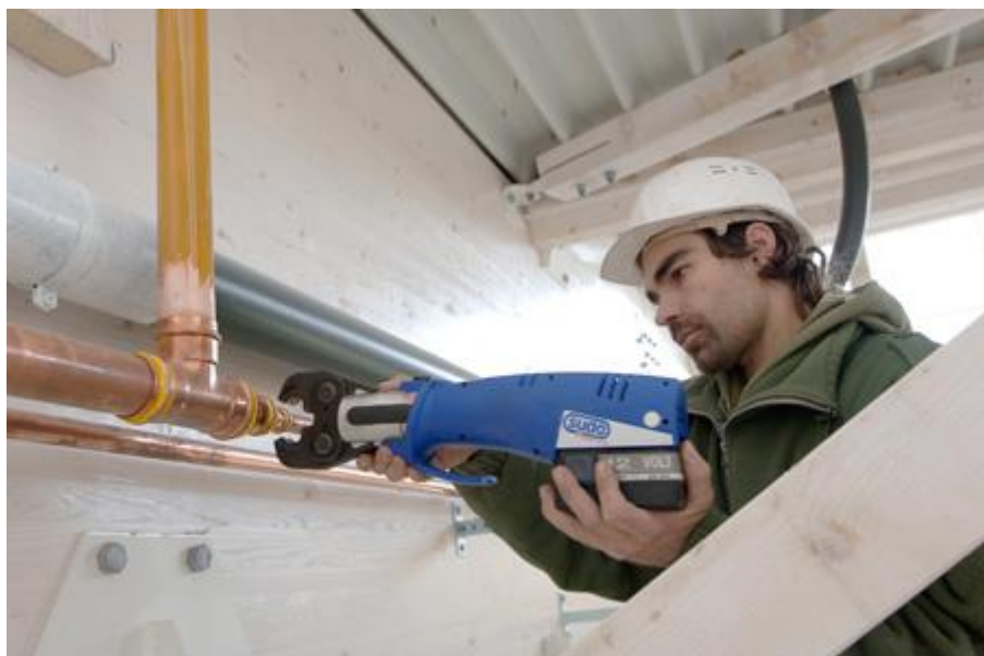
Sertissage sur un piquage en 54 et départ avec une réduction de 22
