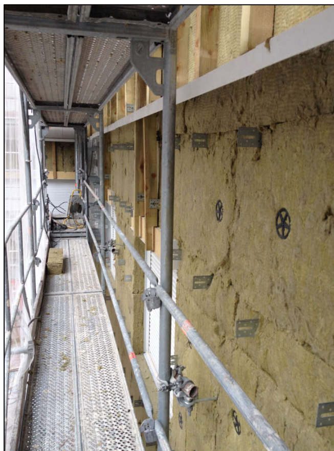
Isolation ITE laine de roche en calé-chevillé
