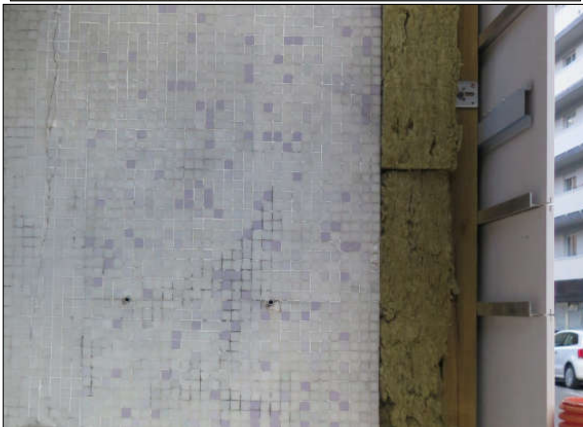
Isolation ITE laine de roche sous-bardage
