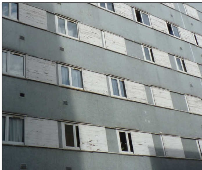
Menuiseries au nu extérieur et volets coulissants
