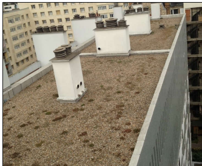
Toiture terrasse inaccessible
