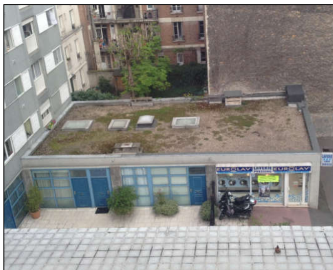
Toiture terrasse du bâtiment RDC
