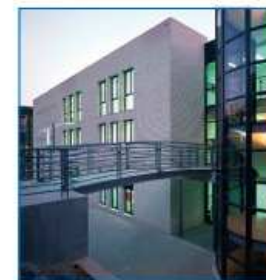
Gestion active des bâtiments
