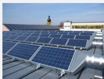
Figure 107: Illustration d'un système hybride en surimposition, source : faz.net
