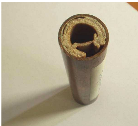
Canalisation en cuivre
