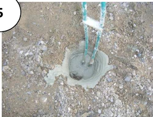
Remplissage du forage avec de la bentonite
