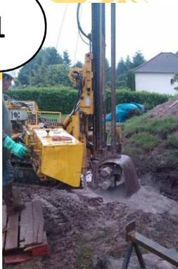
Forage des puits de diamètre 110mm maximum et d'une profondeur de 30m
