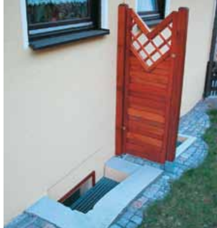
Exemple séparation des flux d'air
