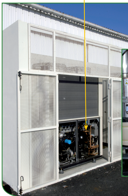
Moteur gaz naturel de la PAC
