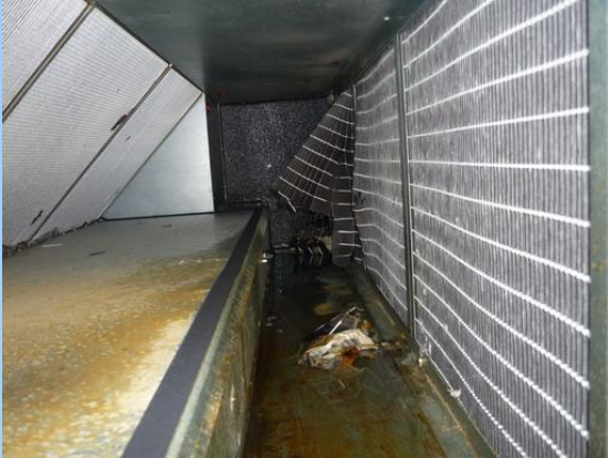
Accumulation d'eau croupie sur le circuit de soufflage...
