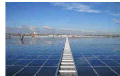
Plus grande installation PV en toiture d'Allemagne - 7,4 MW Goodyear Dunlop à Philippsburg
