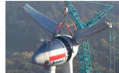
Enercon E-126 Schneebergerhof, Allemagne
