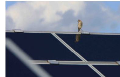
Parc photovoltaïque de Toreilles, Pyrénées Orientales - 12 MW
