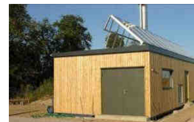
Cabine énergétique Wörrsatdt, Allemagne
