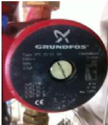
Pompe secondaire solaire est une pompe GRUNDFOS UPS 25-55 180. Ce type de pompe n'est pas conforme à la réglementation sanitaire qui impose le montage de pompe ayant une qualification sanitaire.
