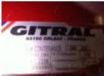
Le vase d'expansion installé sur l'entrée d'eau froide afin de compenser la dilatation de l'eau sanitaire durant sa chauffe n'est lui-même plus sanitaire. Ainsi, il peut rouiller et polluer l'eau sanitaire.
