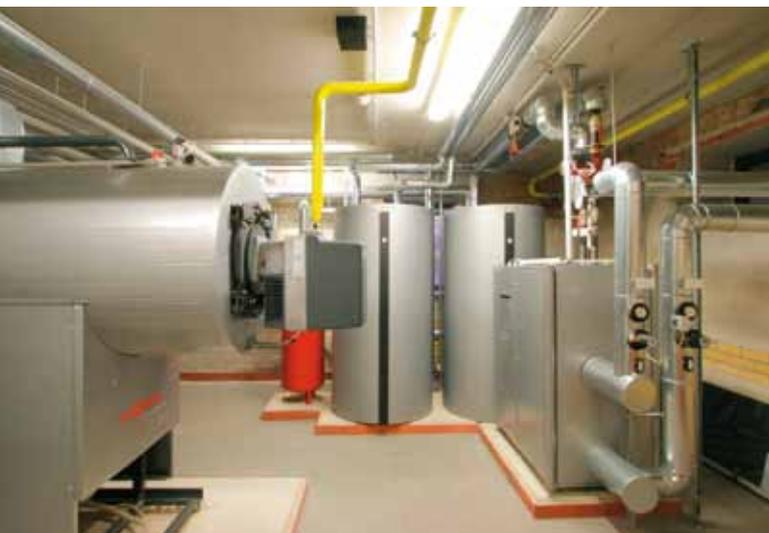
Chaudière gaz à condensation Vitocrossal 300 associée à une PAC et à des ballons d'ECS
