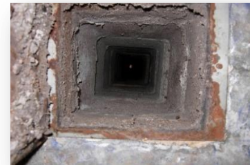
Conduit maçonné (20 x 20)
