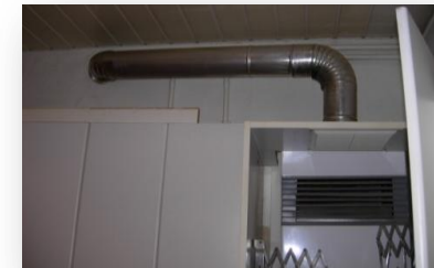
Chaudière Standard raccordée sur CFI
