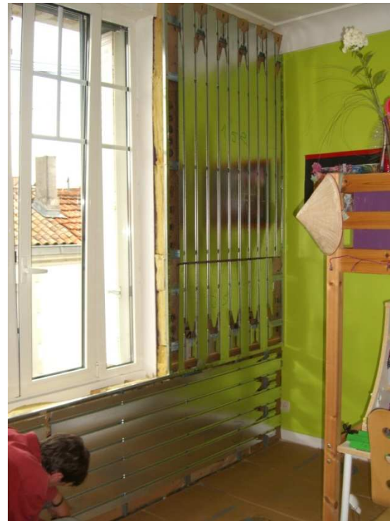
Pose des diffuseurs
