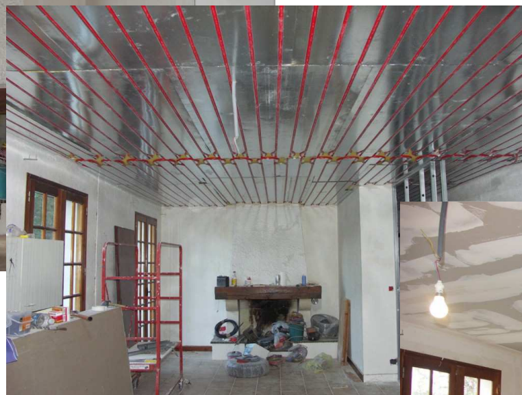
Pose des diffuseurs et du tube
