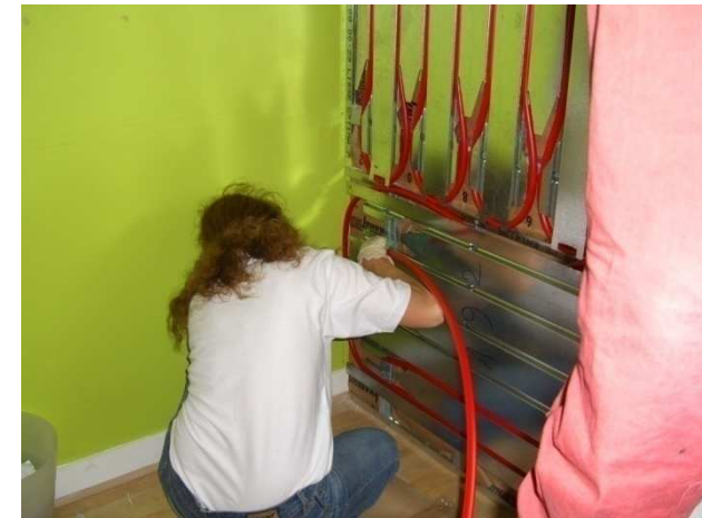
Pose des tubes
