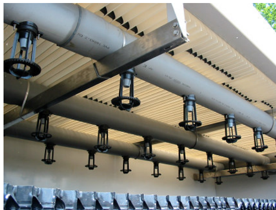
Figure 1H : Système de dispersion du fluide à refroidir
