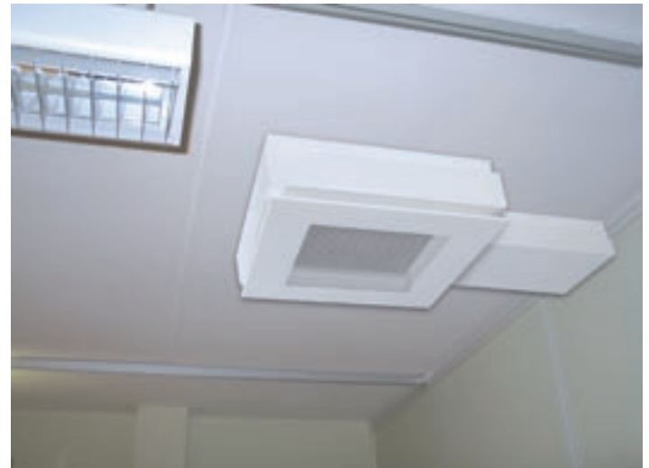
Exemple illustrant un PARASOL EX monté directement sur le plafond.
