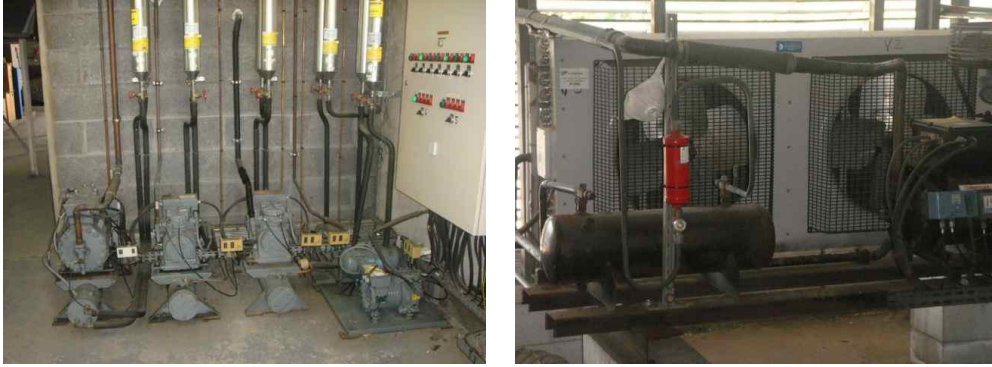
Une partie du froid alimentaire avec 4 compresseurs COPELAND DLSG 401 DWN et un condenseur à air multi-circuits FRIGA BOHN CAP 285 fonctionnant au R22 (HCFC)
