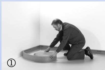
① Pose de la bande latérale
