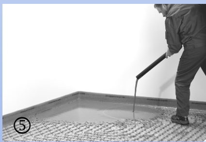
⑤ Coulage de la masse de remplissage
