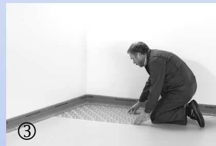
③ Pose des dalles à plots ClimaComfort
