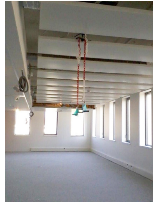
Campagne de mesures dans le Campus Zehnder avant aménagement intérieur
