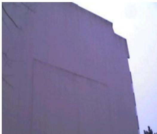
Pignon avec ravalement en bon état,
