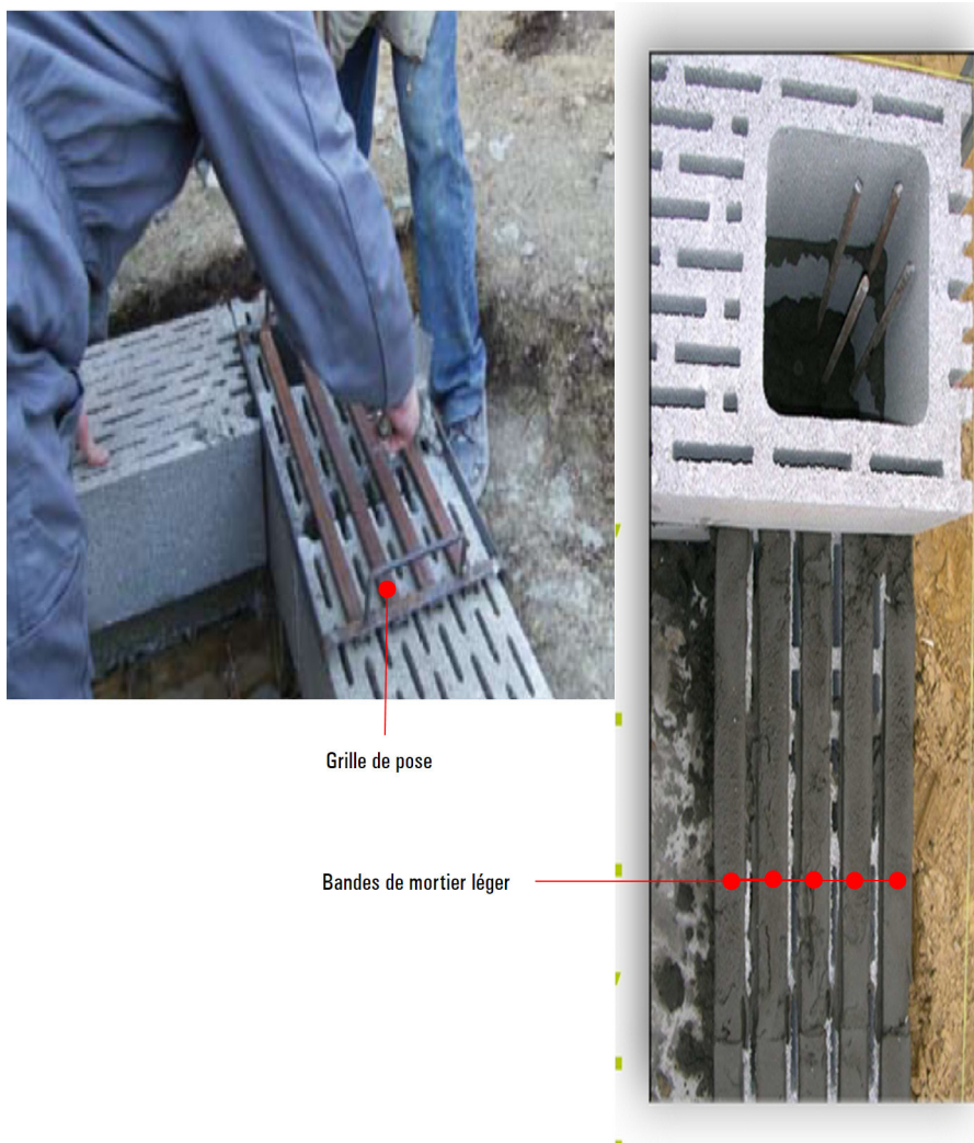
▲ Figure 10 : Mise en œuvre du mortier à l'aide d'une grille de pose
