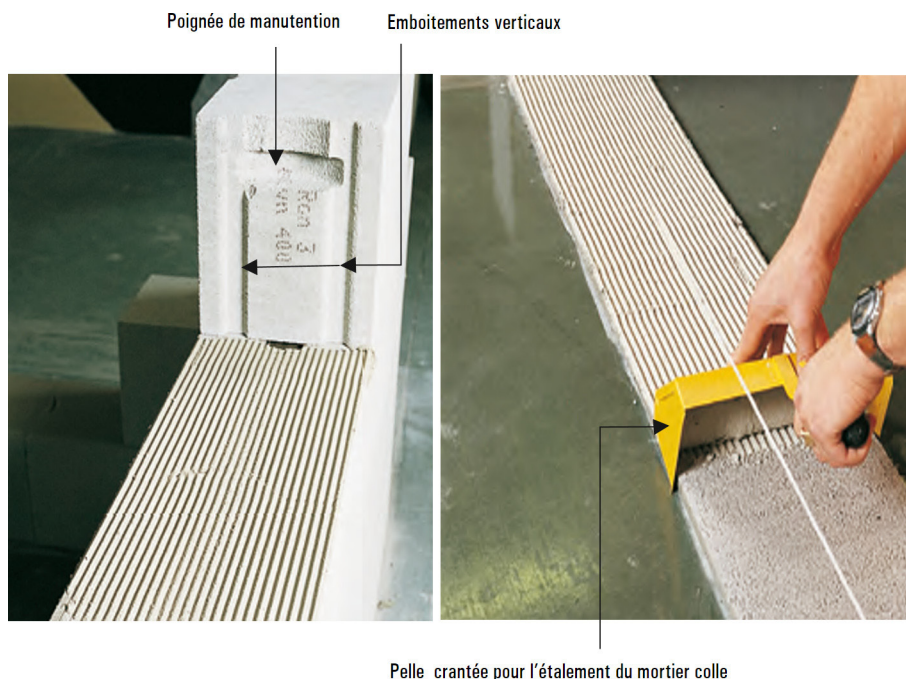
▲ Figure 9 : Mise en œuvre à joint mince par pelle crantée Éléments en béton cellulaire
