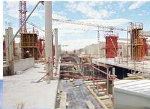
3) Mise en oeuvre
