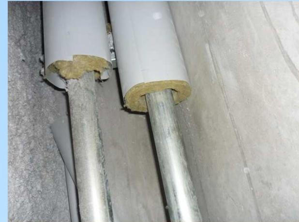
2 - Absence de calorifugeage des réseaux de reprise VMC en terrasse
