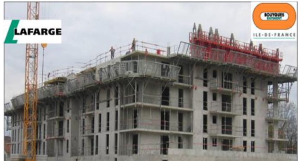
Chantier 3F/ Archi G De CUSSAC
