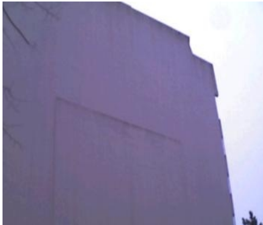
Pignon avec ravalement en bon état,
