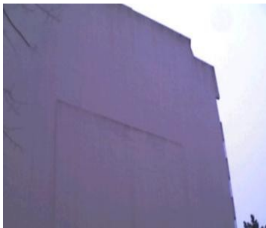
Pignon avec ravalement en bon état,
