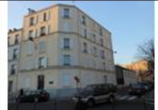
Immeuble rue Chevaleret, Paris
